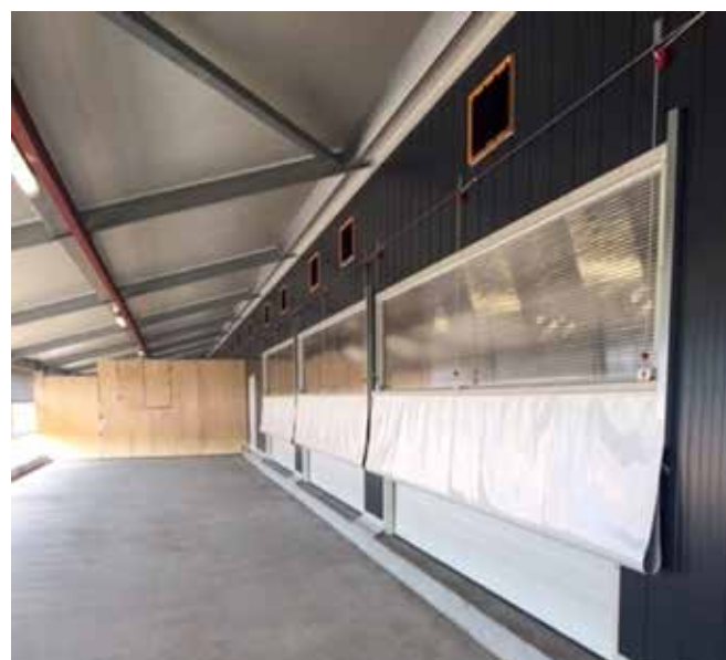
Fig. 3. Mørklægningsvinduer med lameller mellem de to lag glas. @Charlotte Frantzen Bjerg.
